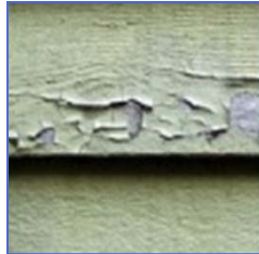
塗装膜が剥がれている
