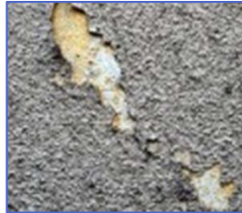
塗装膜が剥がれている
